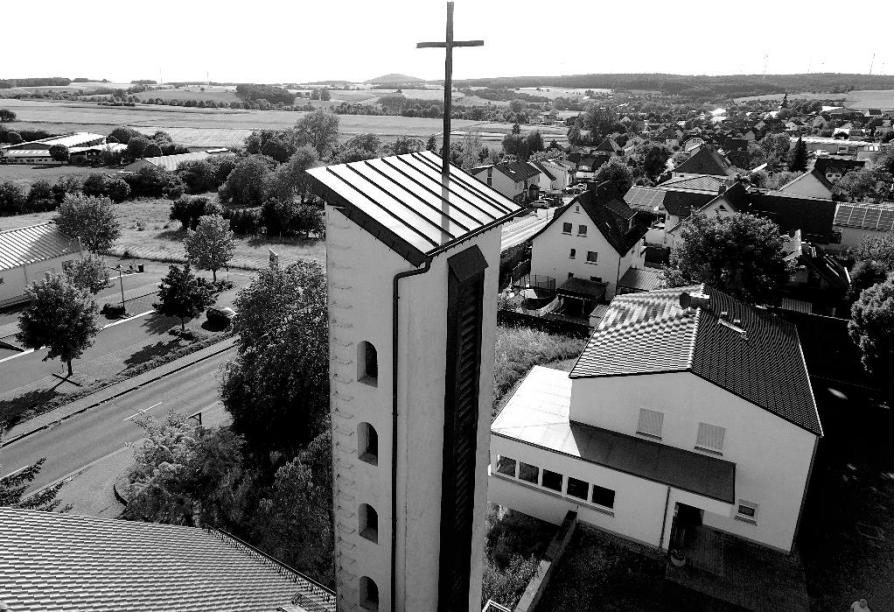
Der Turm der Kreuzkirche von oben (Foto: Bodo Kummert) – In den Nischen hängen die vier Glocken der Kirche. Eine stammt aus Schlesien.
